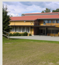
Slåstad skole bygget 1967 og 2000 104 elever
